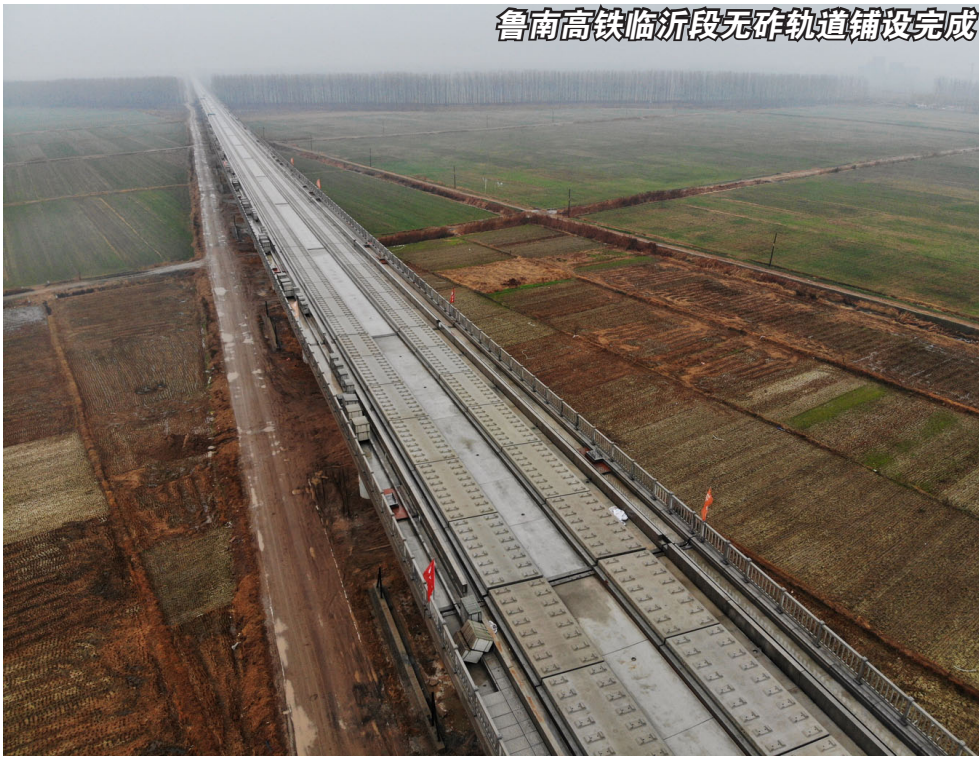
12月2日拍摄的鲁南高铁山东临沂段(无人机拍摄)。
