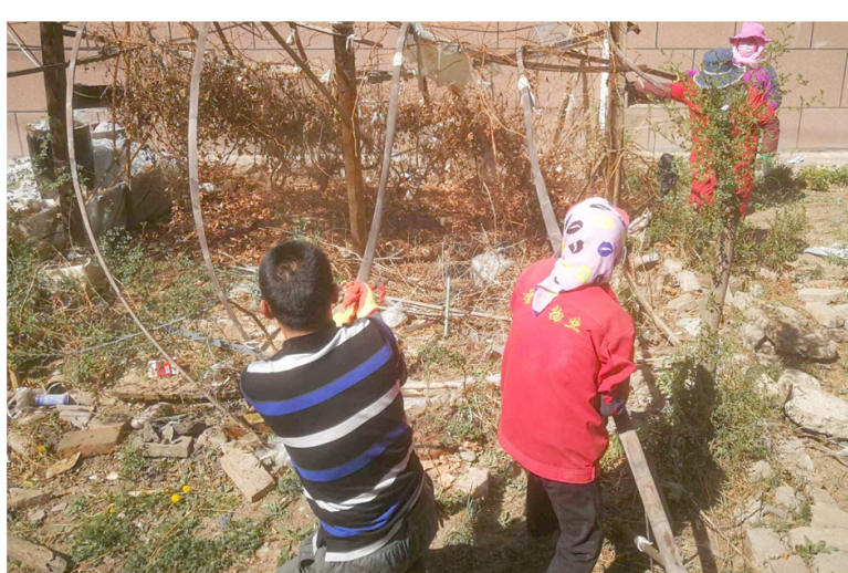
4月17日,本报报道了湟岸巷34号院内绿地上搭建了葡萄架,葡萄架下杂草丛生,还有塑料垃圾一直无人清理的图片新闻后,引起了尔寺巷社区的重视,社区联合小区物业、居民对楼前居民随意搭建的葡萄架、温棚等进行了拆除,并对清理后的空地进行了绿化改造。图为大家正在拆除搭建的温棚。 建文 摄
