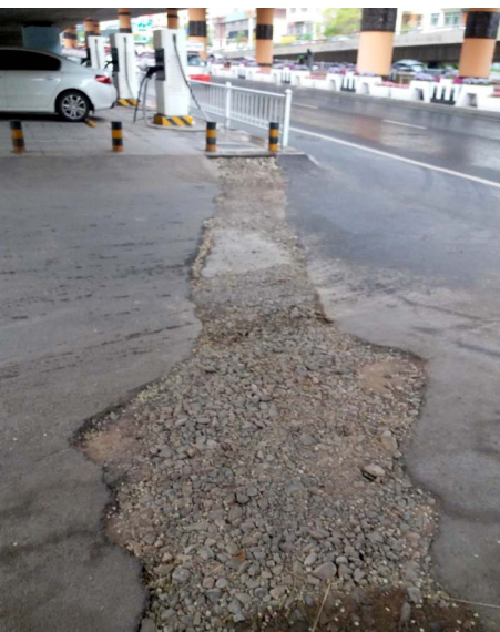
有市民反映,同仁路北段建设汽车充电桩时开挖的道路至今没有恢复路面,砂石裸露,车辆过往颠簸,也影响市容。 微友 李黎光 摄
