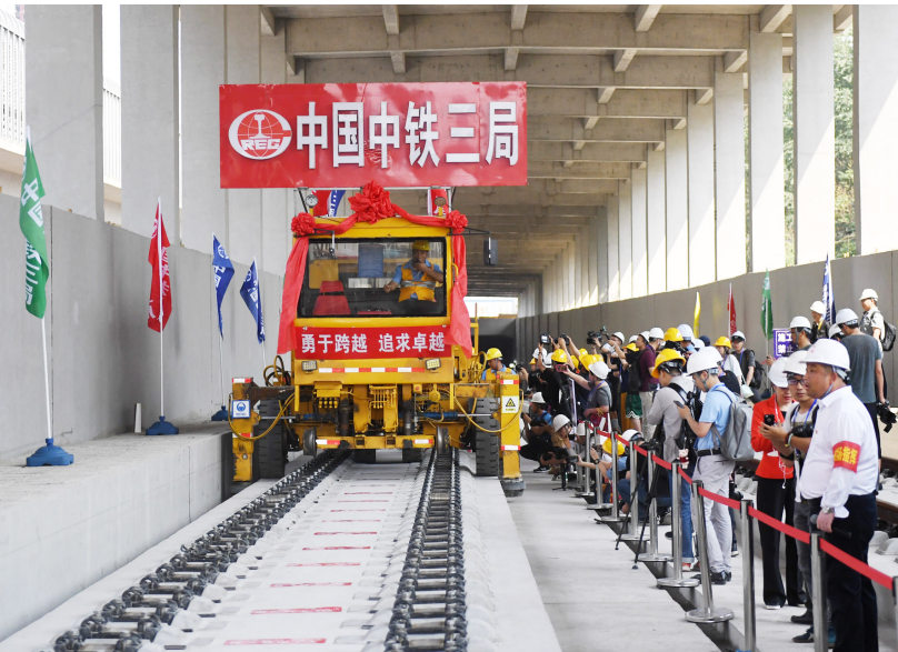
6月12日,铺轨机在京张高铁清华园隧道进行铺轨作业。新华社记者 张晨霖 摄
