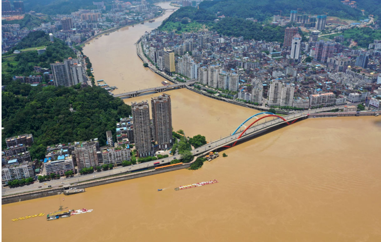
这是洪水经过广西梧州市区的情景(7月16日无人机拍摄)。当日,受强降雨影响,广西梧州市迎来西江2019年第2号洪水,洪峰于当日中午通过梧州市区。12时,西江梧州水文站水位达19.82米,超过警戒线1.32米。新华社记者 陆波岸 摄
