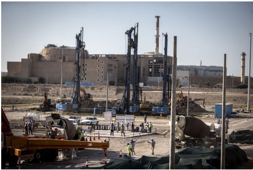
11月10日,工人在伊朗布什尔核电站二期工程现场工作。新华社发(艾哈迈德 摄)
