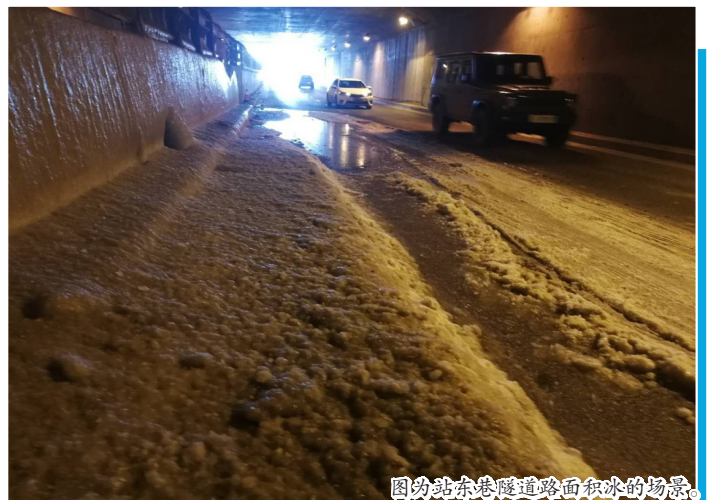
图为站东巷隧道路面积冰的场景。
