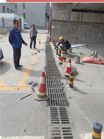
图为施工人员正在安装雨水箅子。
