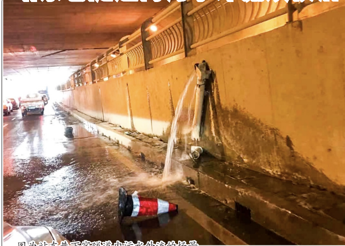
图为站东巷下穿隧道内污水外流的场景。
