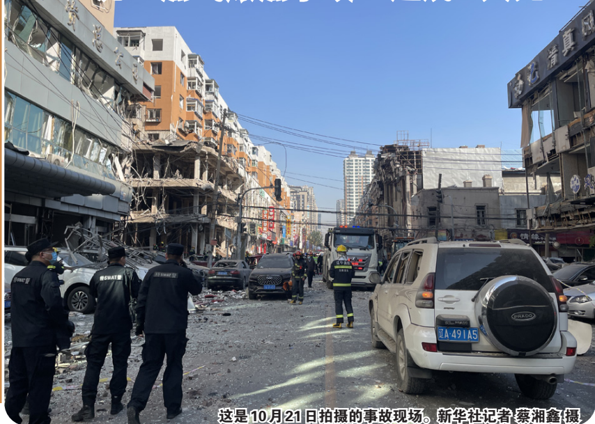
这是10月21日拍摄的事故现场。新华社记者蔡湘鑫摄
