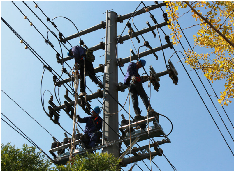
为进一步提高线路运行可靠性和沿线供电能力,方便市民用电安全,日前,线路改迁昆仑西路10千伏湖六路、湖七路路段更换了11台高压隔离开关。图为电力工作人员正在进行作业。张诚睿摄
