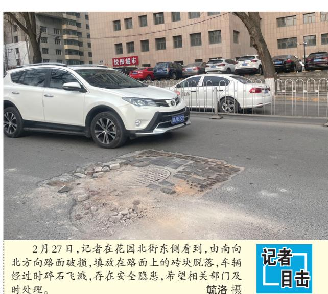
2月27日,记者在花园北街东侧看到,由南向北方向路面破损,填放在路面上的砖块脱落,车辆经过时碎石飞溅,存在安全隐患,希望相关部门及时处理。
