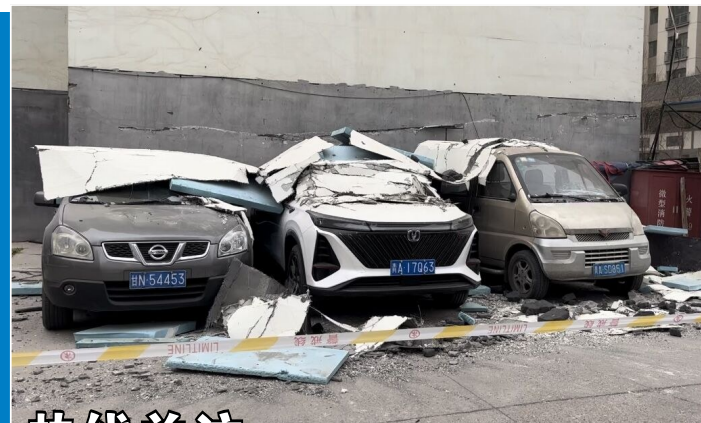
图为被脱落的外墙保温层砸中的车辆。
