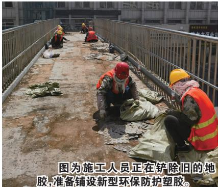
图为施工人员正在铲除旧的地胶，准备铺设新型环保防护塑胶。
