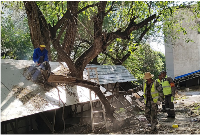
图为施工人员正在商铺屋顶清理枯死的古树。
