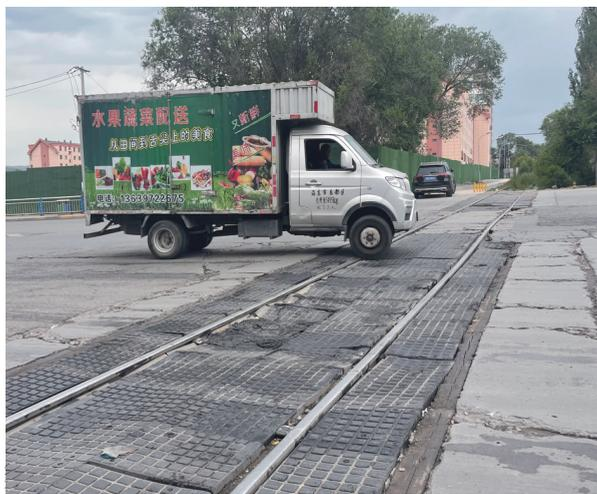
近日,记者在湟水路北口看到,铺设在铁道上的地垫部分已破损、塌陷,车辆经过时颠簸得厉害,希望有关部门能及时更换。 毓洛 摄
