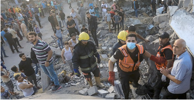
10月17日,在加沙地带南部城市汗尤尼斯,人们在遭以色列袭击损毁的建筑中实施救援。 新华社发(亚西尔·库迪 摄)
