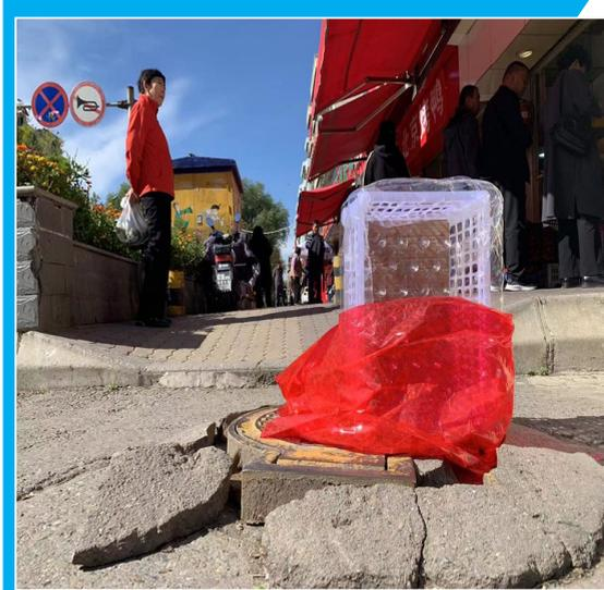
10月21日,有市民反映,南山路南部农贸市场门口一窨井周边的混凝土破损,松动的水泥石块容易绊倒路人,虽然有人放了一个塑料框警示路人,但依然存在安全隐患,希望有关部门及时修复。
