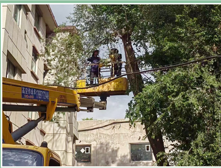
近日,南关街社区工作人员入户走访中了解到,南关街31号、58号、66号、37号和人民街9号均存在树木过高过密,遮挡居民采光的问题,为此社区联系城中区公用服务中心对遮挡采光的15棵树木进行了修剪,受到辖区居民一致好评。 曙光 摄
