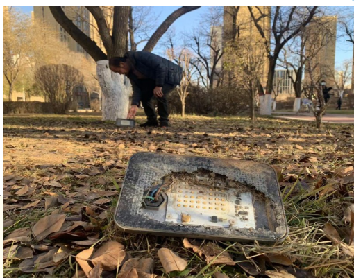
近日,记者在城东区梨园小公园看到,数十盏草坪灯被破坏,无法照明,给附近居民夜间遛弯、锻炼带来很大不便,希望有关部门及时修复。 曙光 摄
