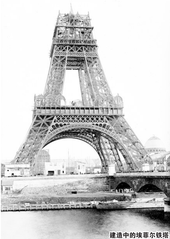
建造中的埃菲尔铁塔
