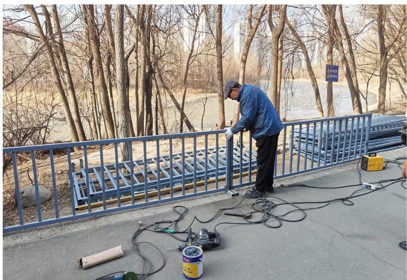
湟水河绿道沿线近50米的路段没有安全防护栏，居民经常在河边散步、遛狗存在安全隐患。3月13日，盐庄社区在沿河路段加装了近50米长的防护栏，并设置了“水深危险”等警示牌，树起了安全防线也改善了河道周边环境。苑柠 摄
