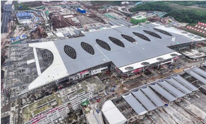
这是5月28日拍摄的重庆东站站房施工作业现场。新华社记者 王全超 摄
