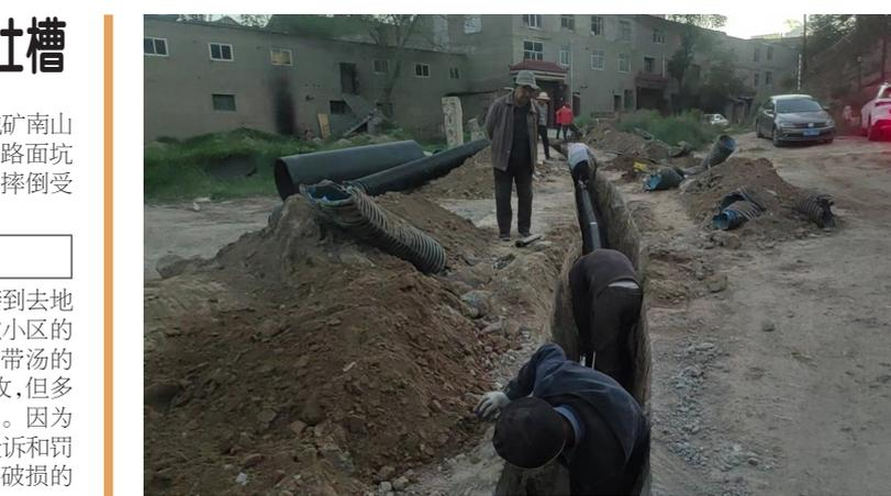
西杏园村西山路下水管网经常出现破损，虽多次维修，但收效甚微，给大家出行带来不便。为了从根本上解决问题，近日，西杏园村委向相关部门申请2.6万元维修资金，联系专业人员对该路段100米长的地下管道进行了改造，从源头上解决了排水不畅的问题。 侏臻 摄
