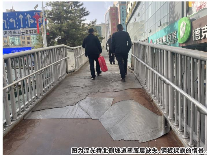
图为湟光桥北侧坡道塑胶层缺失、钢板裸露的情景。
