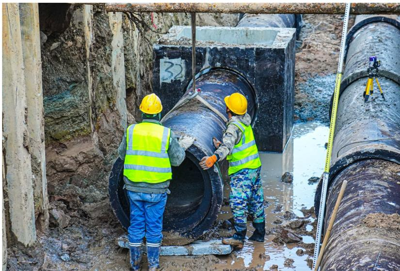
图为祁连路地下排水管网改造施工现场。闫鸿摄
