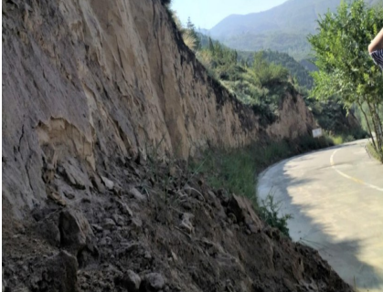
西宁市红叶谷风景区东坡面施工前
