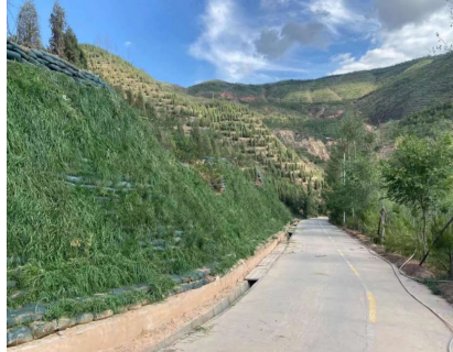
西宁市红叶谷风景区东坡面施工后
