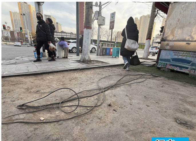
近日,记者在勤奋桥北端看到,人行道出入口旁有数条黑色线缆扔在地上,易绊倒路人也易遭到破坏,希望有关部门能够妥善处理。 毓洛 摄
