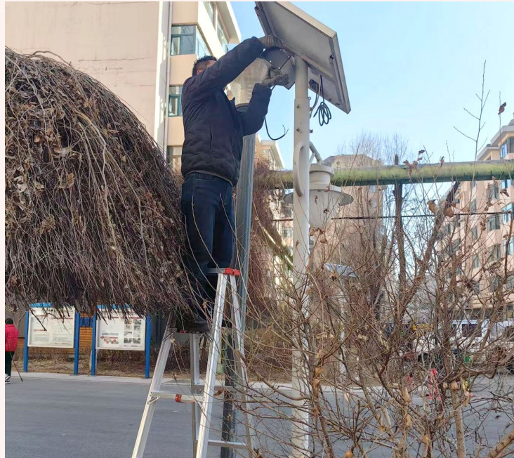
近日,铁道南小区居民反映,小区路灯设施年久失修,大家出行不便。火车站社区工作人员接到反映后,协调相关部门更换了小区原有的40盏太阳能路灯,并清洗了太阳能板,照亮了居民的回家路。
