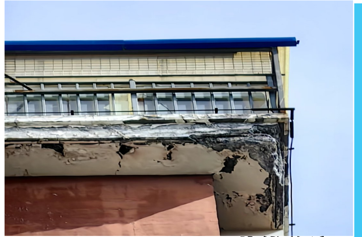
图为楼顶外侧水泥块掉落后的情形。
