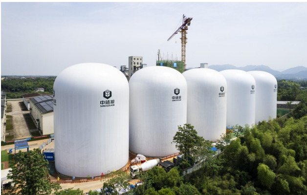
这是5月6日在中储粮长沙直属库拍摄的气膜粮仓建设施工现场(无人机照片)。 新华社记者 陈思汗 摄
