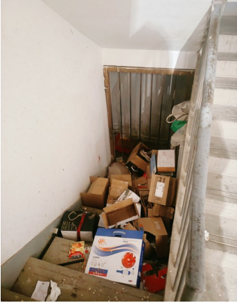
图为小区楼道内垃圾堆积的场面。
