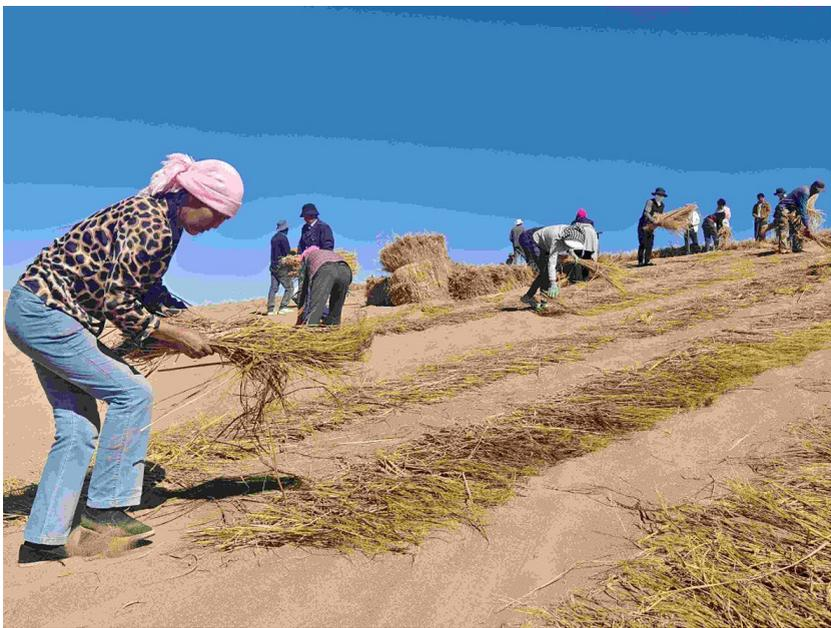
盛夏时节,海西州都兰县夏日哈沙化土地封禁保护区内,暑气蒸腾。几十名园林工作者正俯身在滚烫的沙地上忙碌,开沟的铁锹起落间扬起细沙,铺草的双手在沙垄间穿梭,覆沙的脚步踏过刚成形的网格……一道道工序衔接紧密、井然有序。随着他们的劳作,成片的草方格在原本荒芜的荒漠上不断延展,一条条坚韧的金色锁链,将曾经肆意流动的黄沙牢牢锁住,在骄阳下勾勒出充满希望的绿色轮廓。
