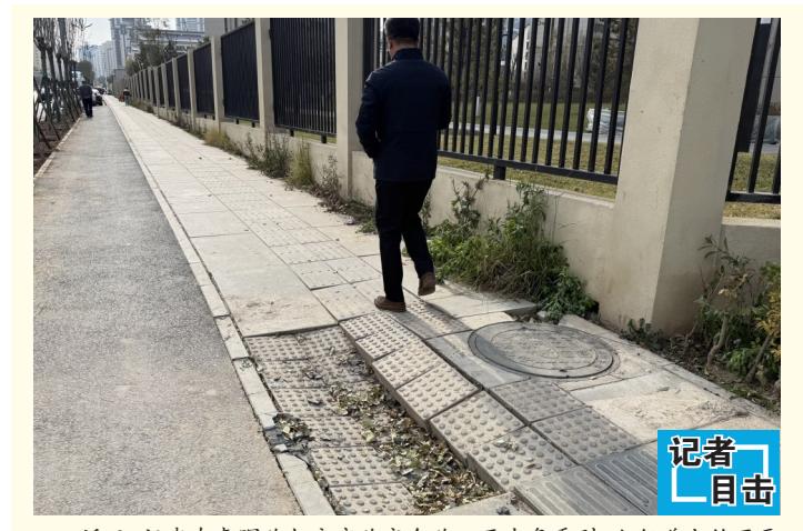
近日，记者在春晖路与安宁路交会路口西南角看到，人行道上约两平方米的地砖下陷，形成十余厘米深的沟槽，相连的部分地砖也出现松动、倾斜，给过往行人通行带来隐患，希望有关部门能够及时修复。 毓洛 摄
